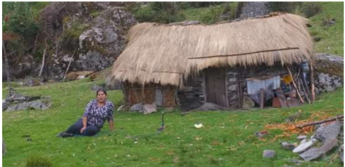
Construcción terminada de la casa de paja, actualmente ya esta habitada
