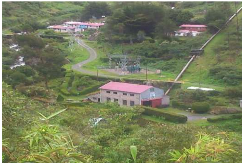
Planta generadora de energía eléctrica para Oruro y La Paz
