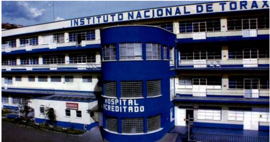
Infraestructura del Instituto Nacional de Torax
