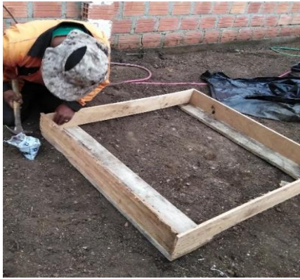
Construcción y armado de las piscinas flotantes
