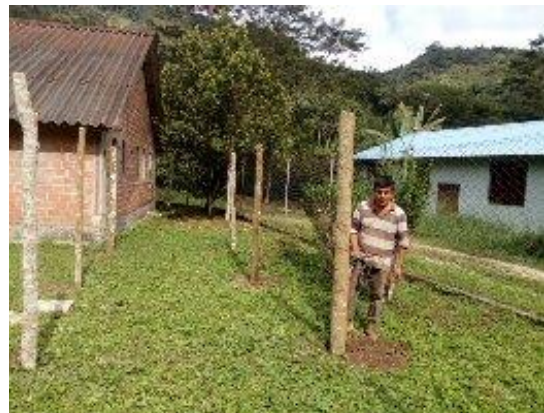
Construcción del vivero.
