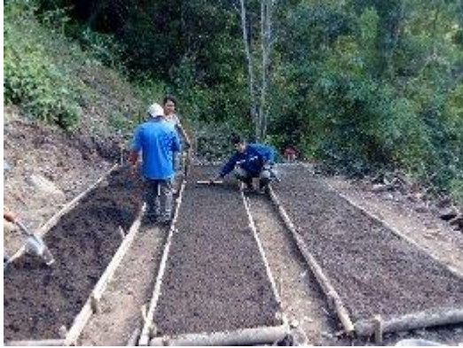
Construcción de almaciguera.
