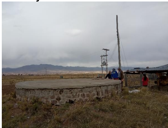
Figura 39. Pozo subterráneo y su reservorio circular
