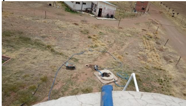
Figura 53. Pozo superficial dos
