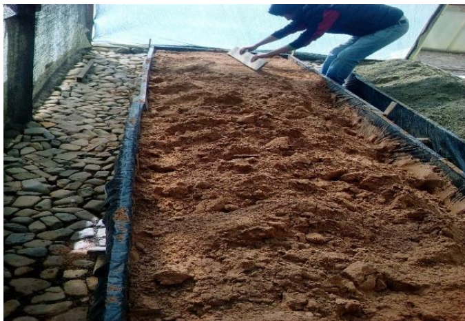
Figura 2. Armado de la platabanda y el vaciado de la arena
