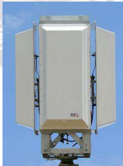
Figura 29: Estructura de la antena de Panel.
