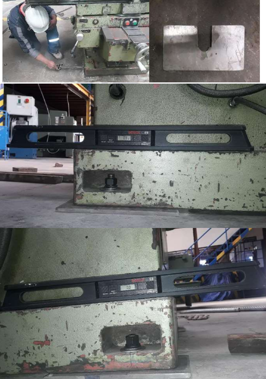
Fotografía 2. Proceso de nivelado
