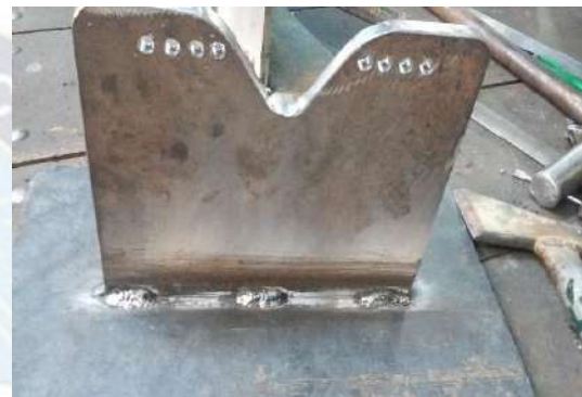
Fig. 3.27 Ejecución del trabajo.
