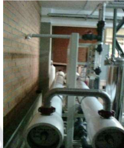
Fig. 3.2 Instalación de ducto PVC.
