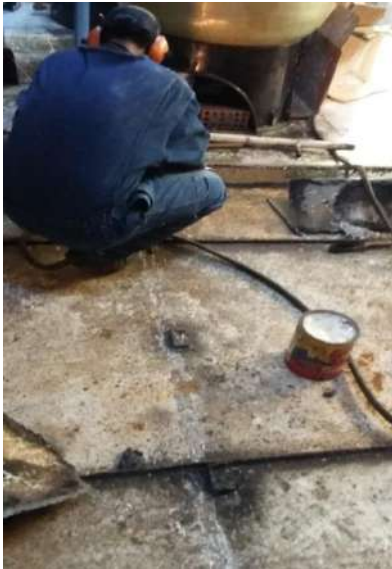
Fig. 3.20 Desmontaje de tanque de gas.
