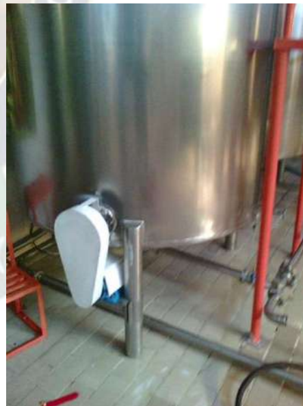
Fig.3.13 motor antes de ser desmontado.
