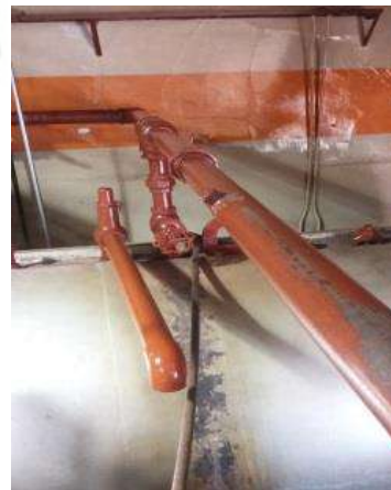
Fig. 3.25 Pintado de ductos según norma.
