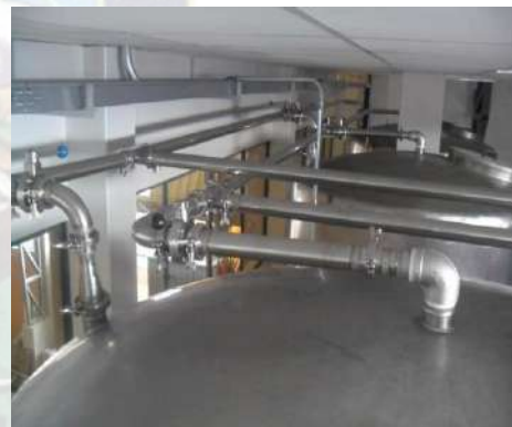
Fig. 3.32 Punteo (codo y unión clamp). Fig. 3.33 Armado de ductos.
