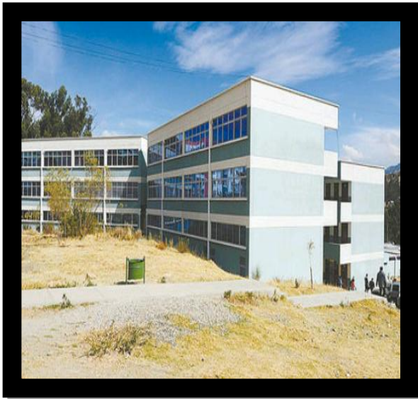
Amorruga, W. y Ticona, P. (2018). Predios de Cota Cota. [Fotografía]. Archivo de Auditoria Interna
