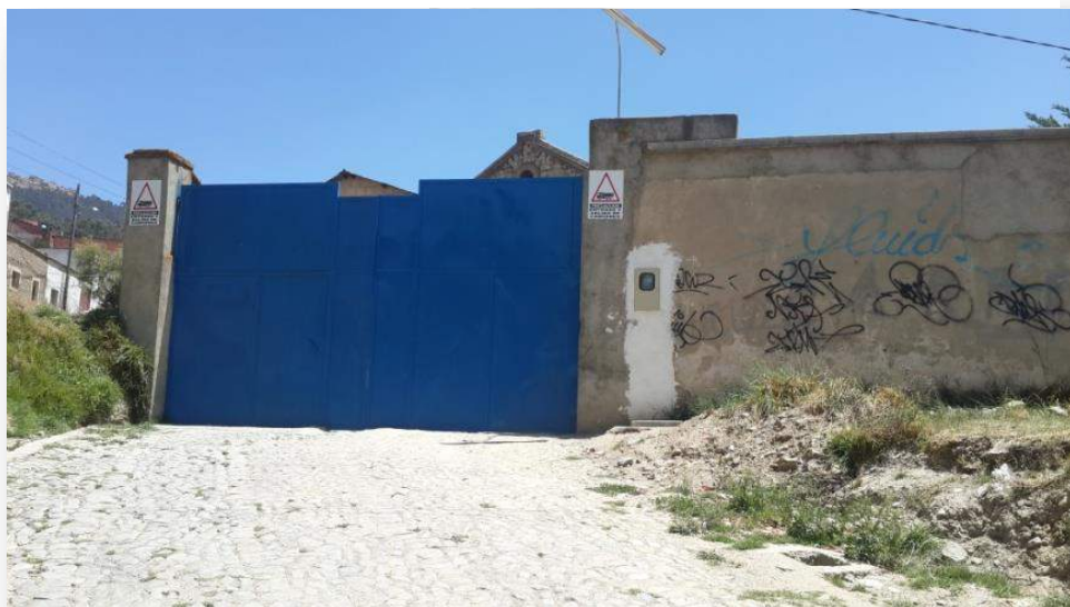
Ilustración 2 Vista frontal de la planta de Pura Pura
