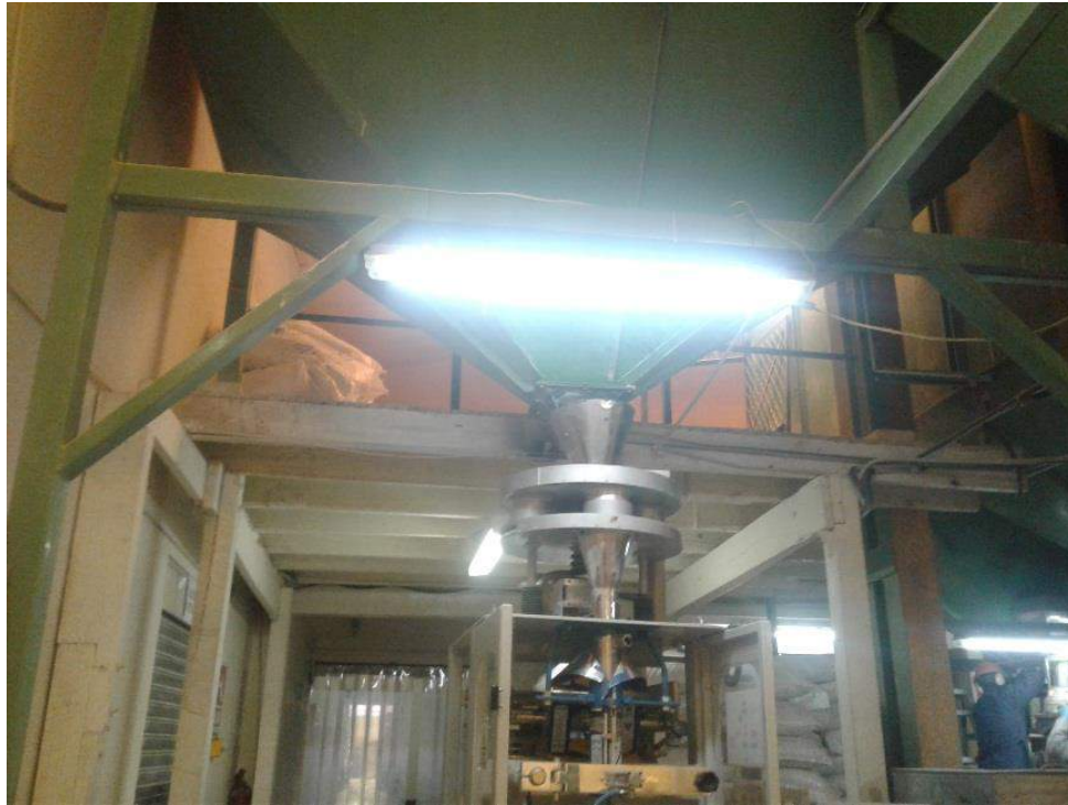
Ilustración 7 Evidencia cambio de luminarias
