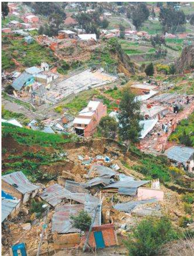
Destrucción. Viviendas desplomadas en la zona de Callapa.
