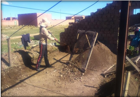
Preparación de terreno
