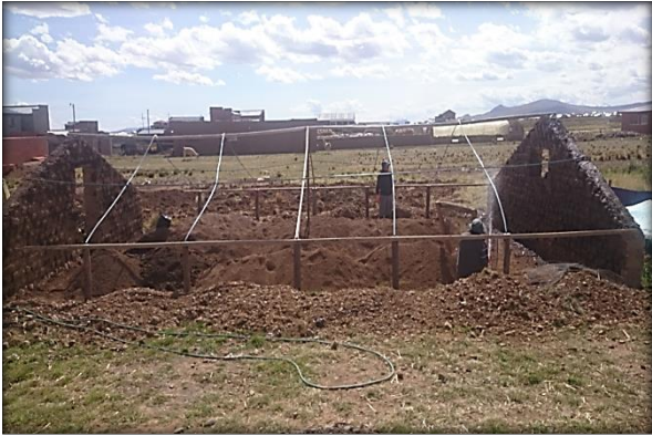
Construcción de Carpa solar
