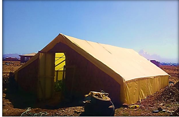
Techado de la Carpa Solar
