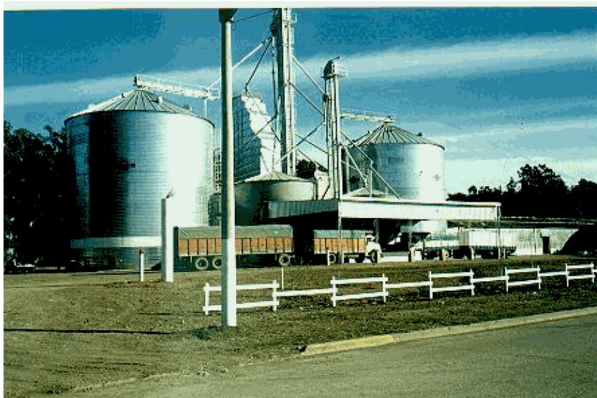
Silos especialmente adecuados para el almacenamiento de trigo en Grano de diferentes procedencias (americano, canadiense, etc.)
