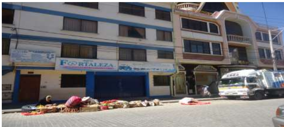
Este es la Centro de Rehabilitación Física y Educación Especial CEREFÉ y a su lado está ubicado el Local “ MILENIUM a su frente está el salón “PRIMAVERA” y “PARÍS”.
