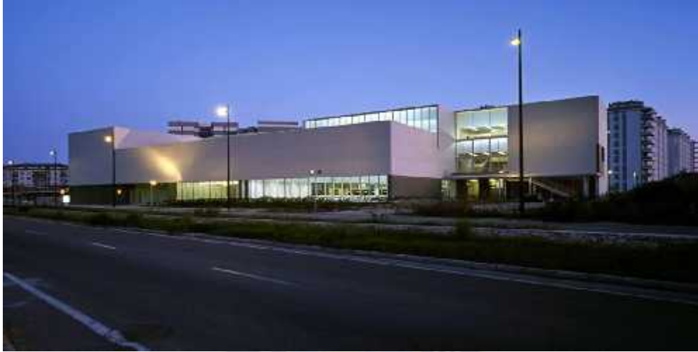
Figura 35 Vista frontal del edificio
