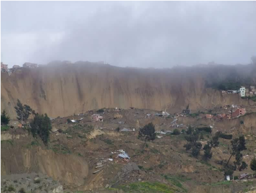
Area afectada vista desde Irpavi
