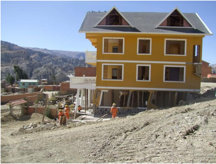
Despues del deslizamiento, una casa aun de pie, planta baja afectada
