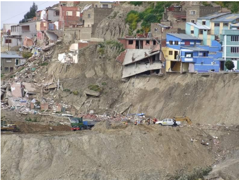
Despues del deslizamiento, una casa aun de pie, planta baja afectada
