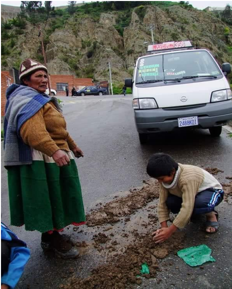
Señora y niño intentado cubrir grietas del asfalto
