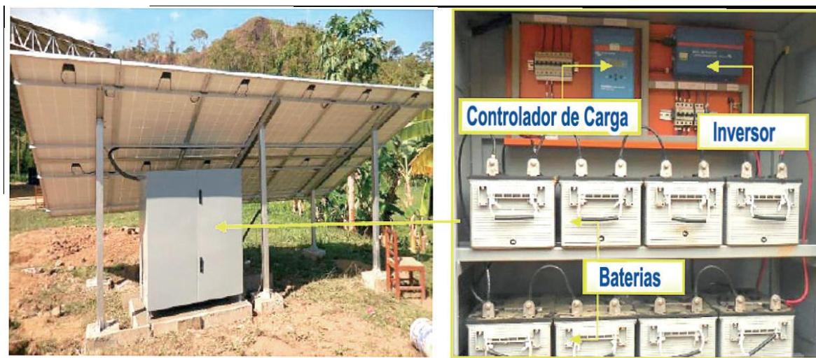
Figura Nro. 4.21. Componentes panel solar <sup>42</sup>
