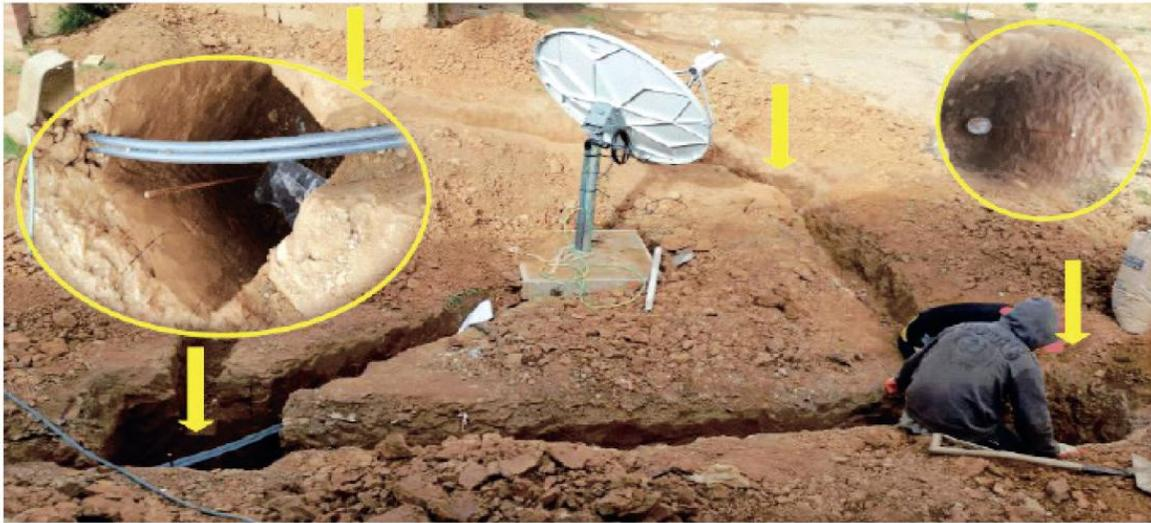
**Figura Nro. 4.17.** Vista instalación sistema de aterramiento (Fuente propia)
