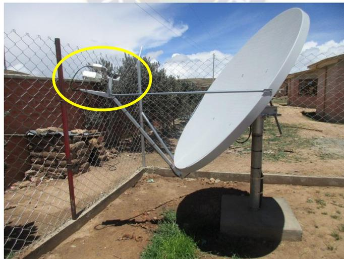
Figura Nro. 4.26. Vista de Antena, LNB y BUC (Fuente propia)
