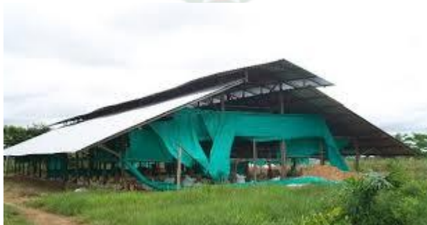
Figura 7: tipo dos aguas con claraboya
