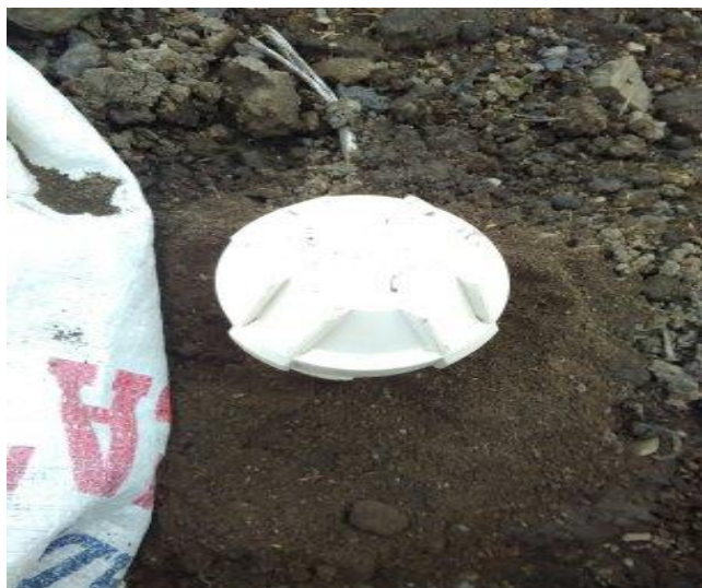
Figura 8. Instalación de tubos PVC (Diviner)
