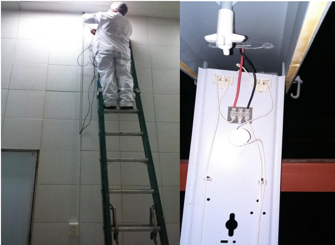
Fotografía 14 (Mantenimiento de Luminarias)
