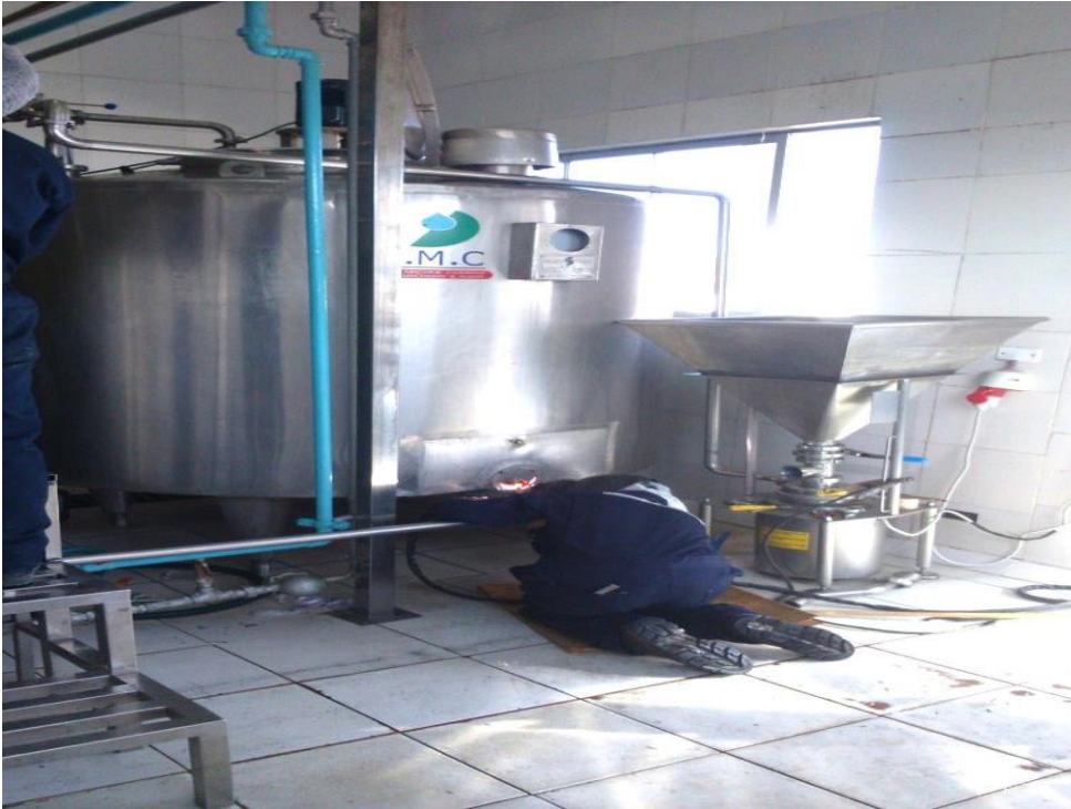
Fotografía 13 (Mantenimiento de Tanque de Acero Inoxidable de 1000 lt.)
