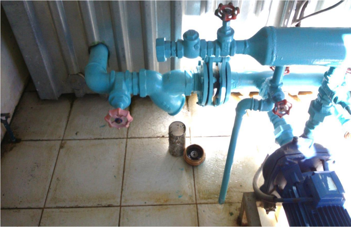
Fotografía 7 (Limpieza de Filtro de Agua)
