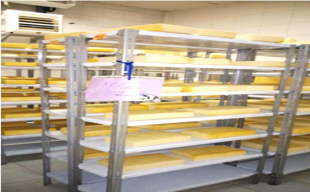
Fotografía 11 (Cámara de Maduración y Pre maduración de Queso)
