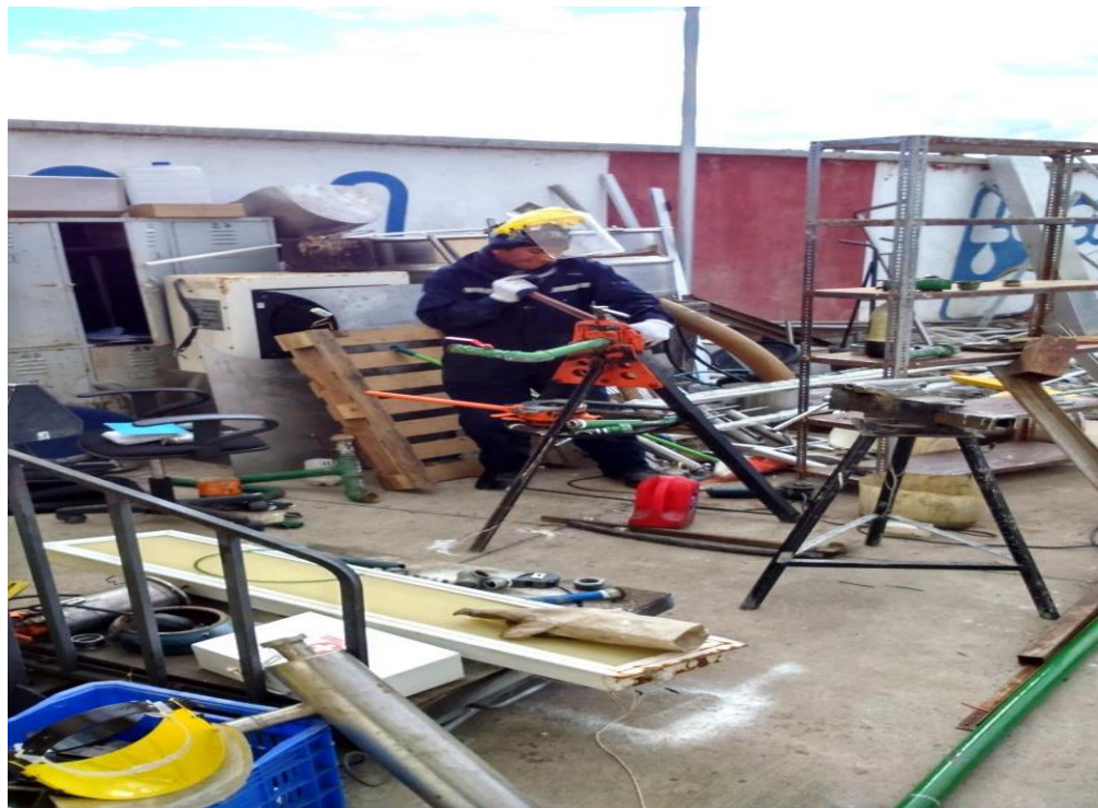
Fotografía 10 (Cortado de Tubos para Líneas de Agua)
