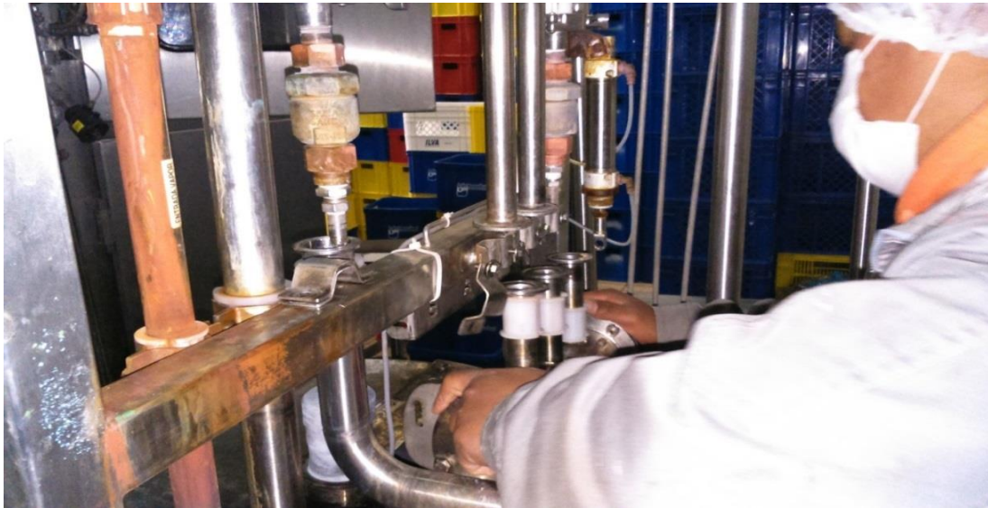
Fotografía 3 (Cambio de Empaques de Líneas de la Homoginizadora)
