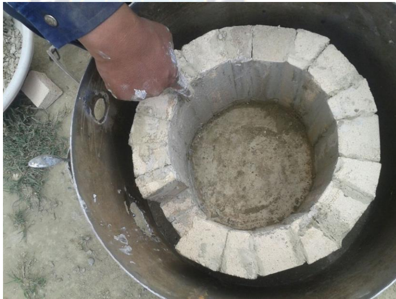
Fig. 26. Moldeado de ladrillo refractario
