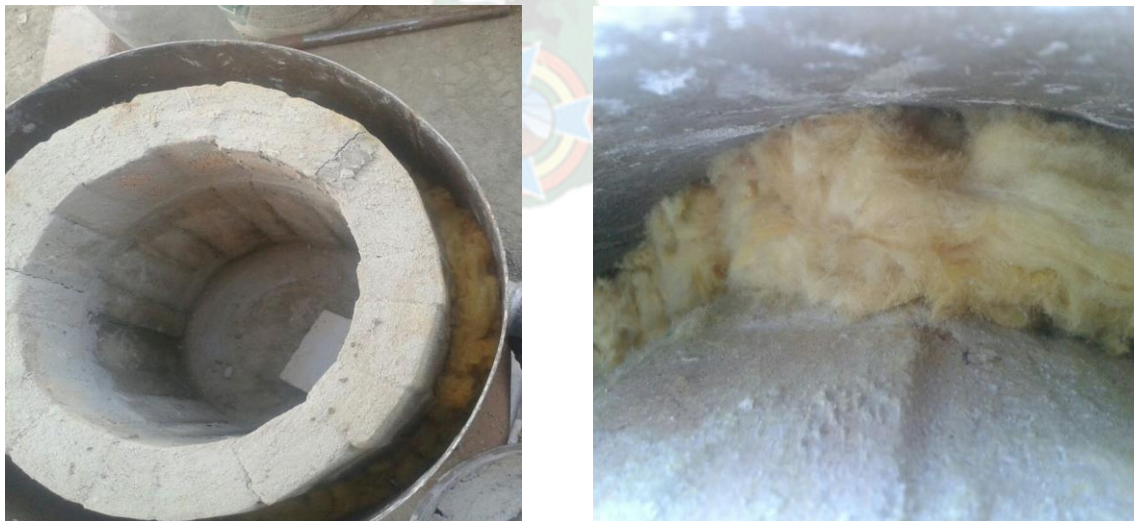
Fig. 28. Instalación de lana de vidrio o manta refractaria.
