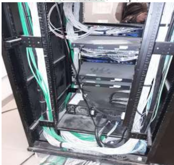
Figura: 35 Peinado de Rack Fuente: Elaboración Propia
