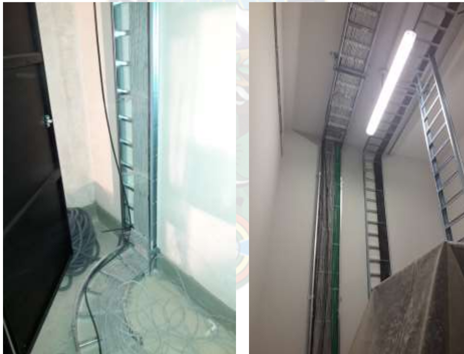
Figura: 31 Tendido de cable UTP Cat 6 Furukawa en la Bandeja
