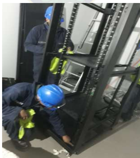
Figura: 33 Ubicación de Rack y la ubicación de los ordenadores horizontales y verticales Fuente: Elaboración Propia
