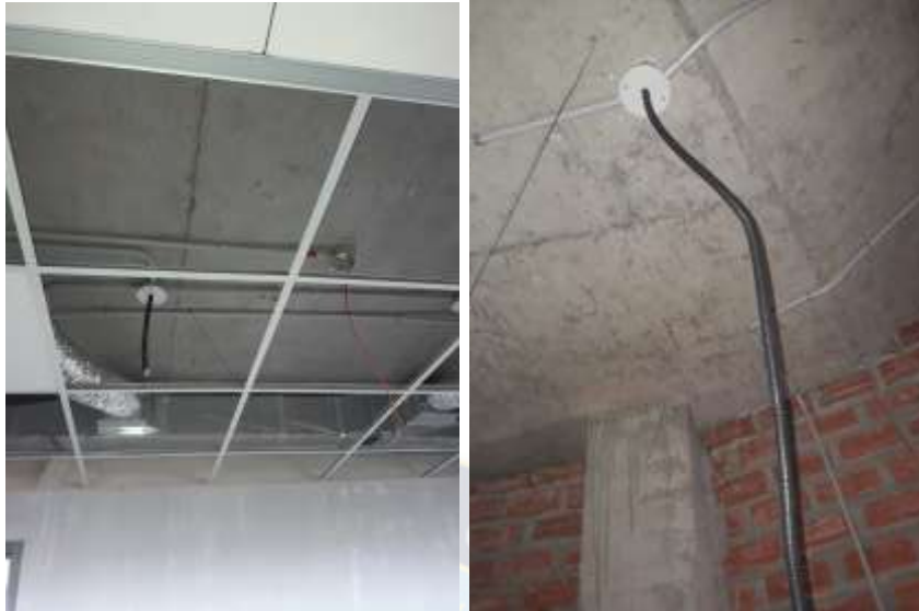
Figura: 27 Ducteado PVC en lugares con techo falso Fuente: Elaboración Propia
