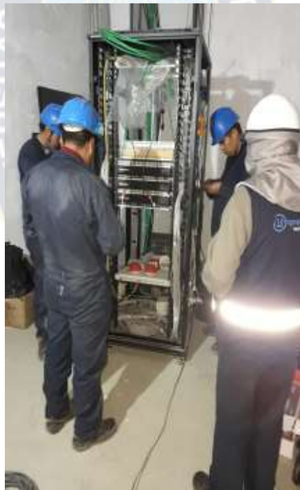
Figura: 36 Conectorizacion y Ponchado de cable UTP Cat 6 en cuarto de Telecomunicaciones Fuente: Elaboración Propia
