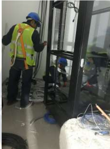
Figura: 32 Armado de Rack Fuente: Elaboración Propia
