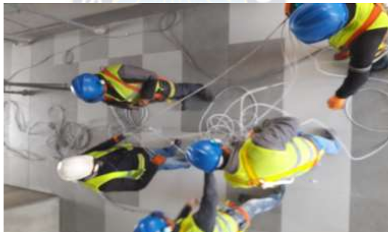
Figura: 30 Tendido de cable UTP Furukawa categoria 6 Fuente: Elaboración Propia
