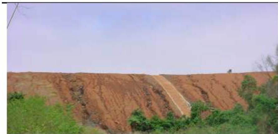
Vista panorámica del depósito de sulfuros, donde se evidencia procesos de erosión y falta de cobertura vegetal
