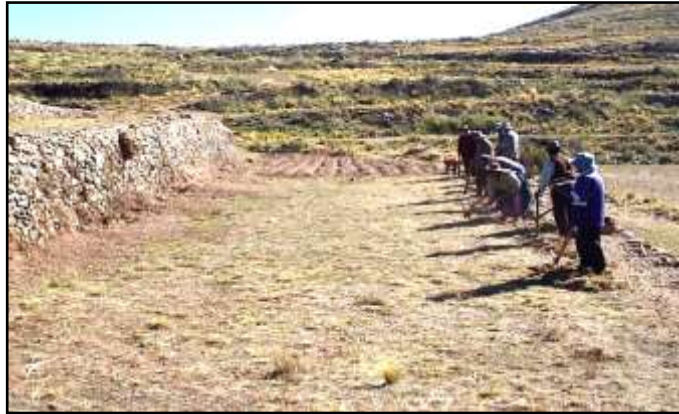
Fotografía 10. Plataforma reconstruida (Plaza V. 2010)
