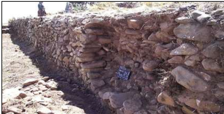
Fotografía 14 Muro que se reconstruyo (Alvarez R. 2009)
