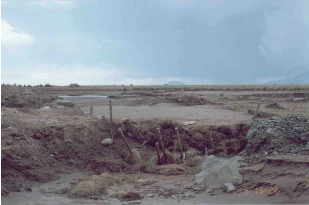
Figura 5. Tape de la Boca Toma de Puman Challa con Materiales Locales (Chillpis)
