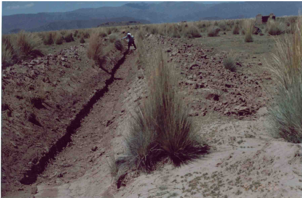
Figura 4. Limpieza de Canales Secundarios, Zona de Riego Palquiri
