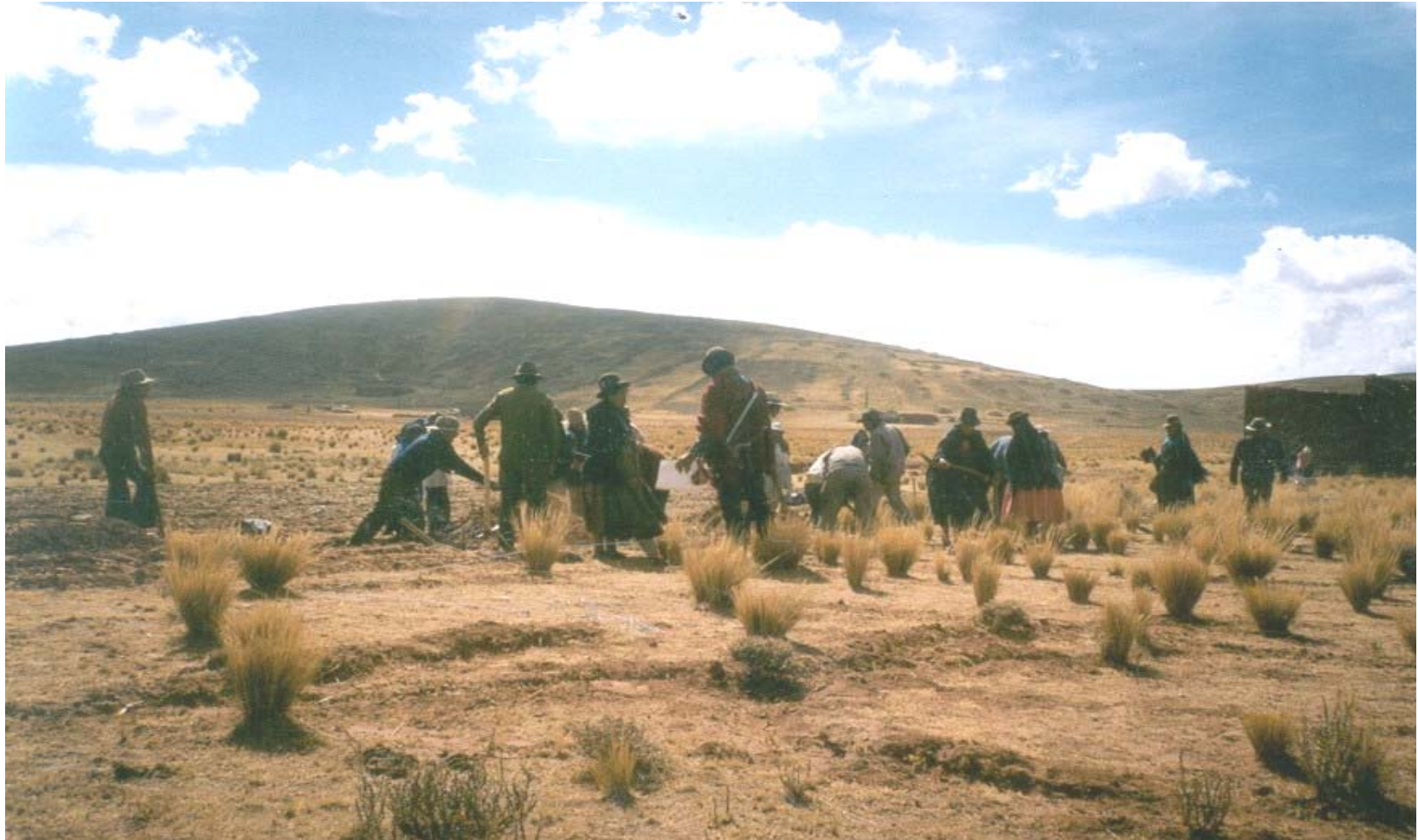
Fotografía 1 Inicio de Excavación (Escuela de Contorno Centro)
