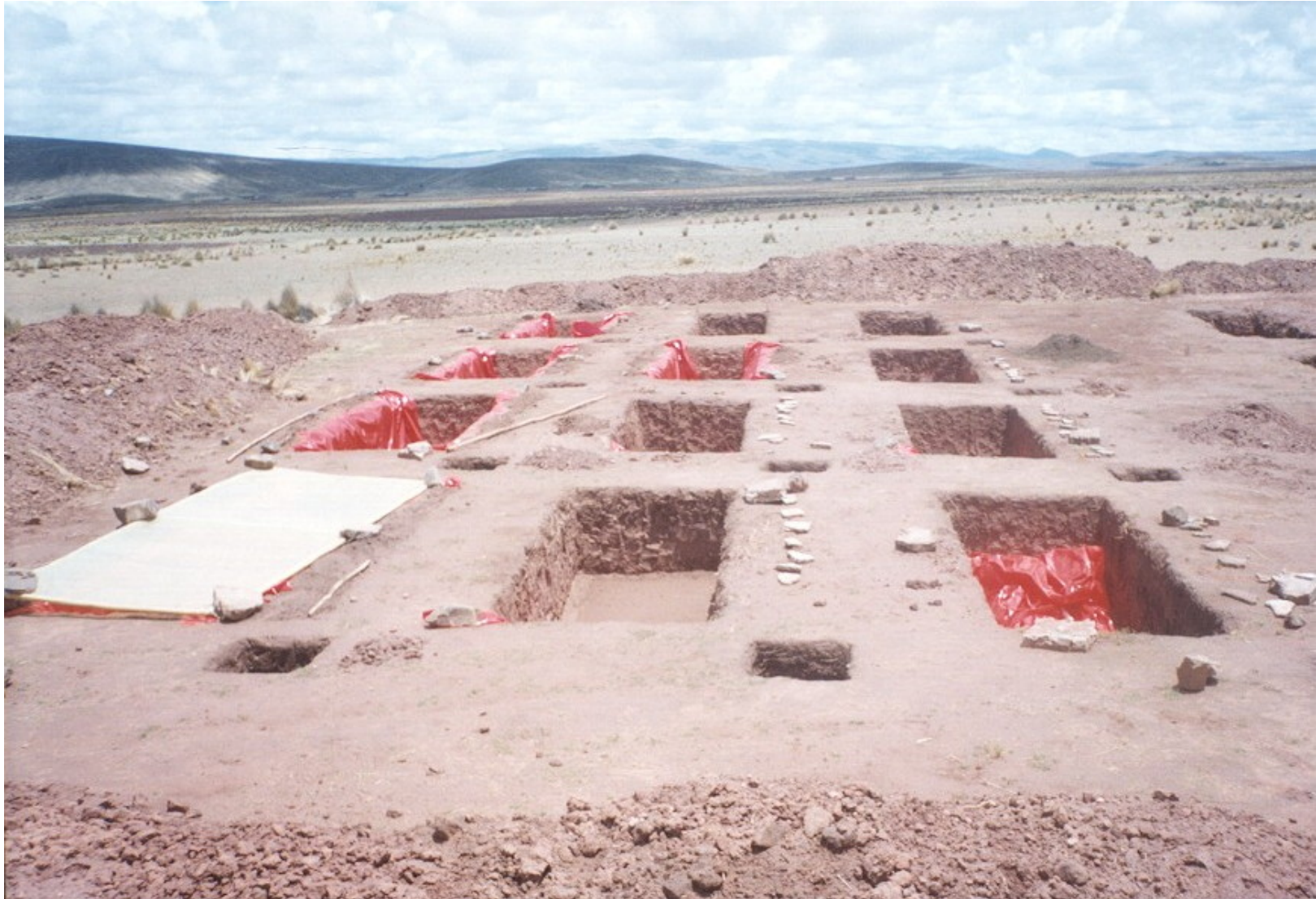
Fotografía 4 Instalación de lisímetros (impermeabilización y drenaje)
