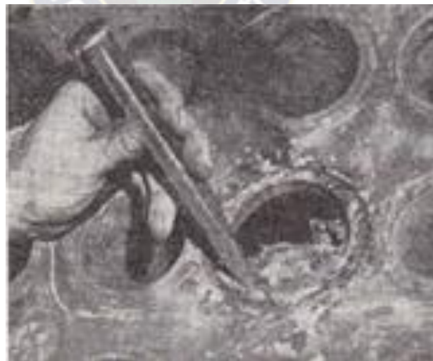
Fig. 10.7 Eliminación del extremo soldado del tubo.
