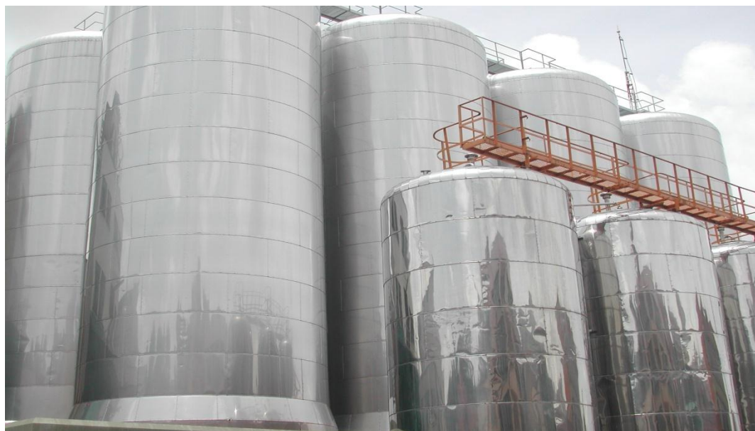
Tanques de Fermentación
