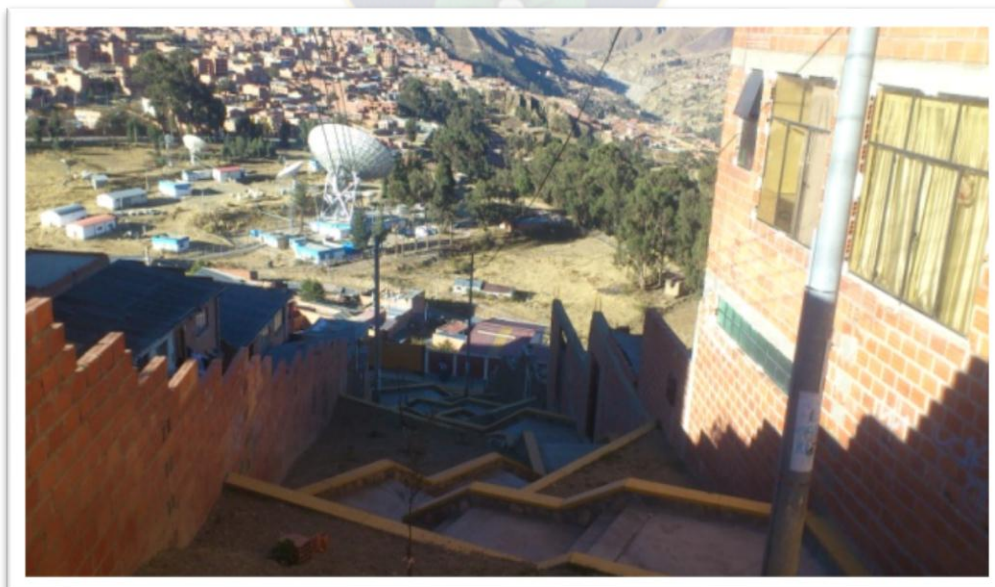
Fotografía N°4: Panorámica del área de trabajo
