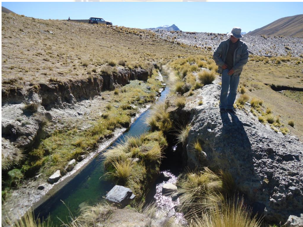
Vista parcial del canal de riego existente
