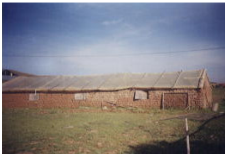
Vista de la carpa solar
