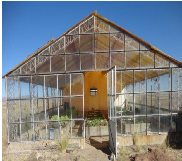
Figura 2: Infraestructura del invernadero.
