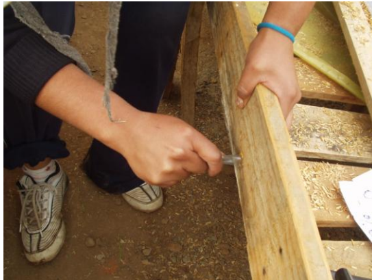
Fig. 7 Colocado de drenaje al contenedor
