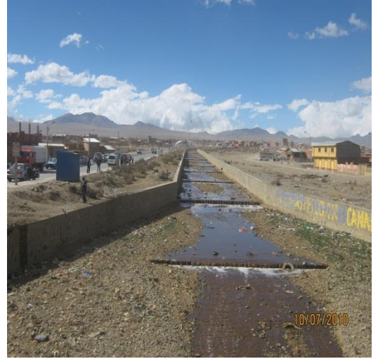
Puente Bolivia D-3
