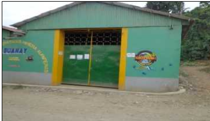
Fotografía N° 8: Infraestructura de las organizaciones sociales
