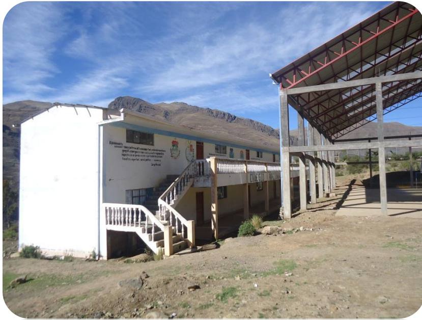
Infraestructura De La Unidad Educativa Ichoca II
