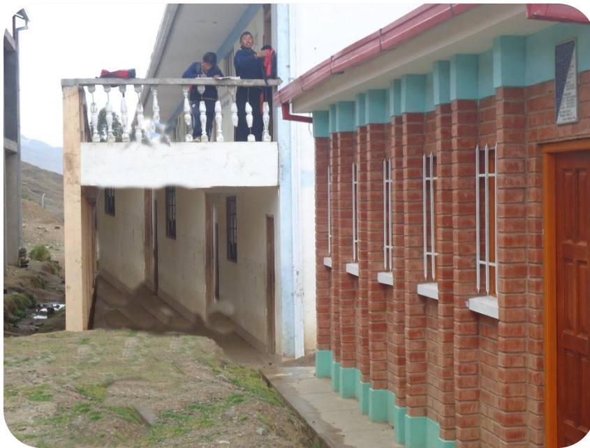
Infraestructura De La Unidad Educativa Ichoca II
