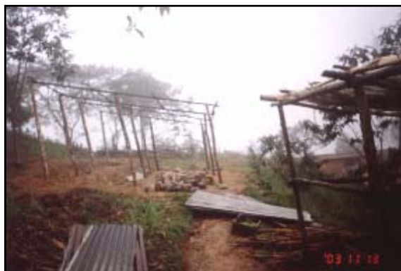
Fig. 3.6. Construcción de Lombricario
