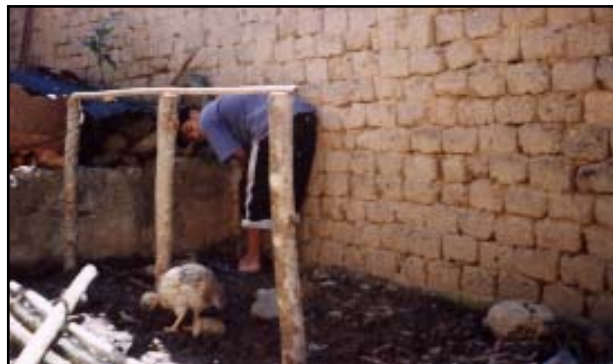
Fig. 3.33. Construcción del Armazón de la Cuna de Lombrices
