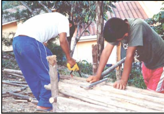
Fig. 3.13. Estudiantes Rellenando el Armazón de Troncos con Charos
