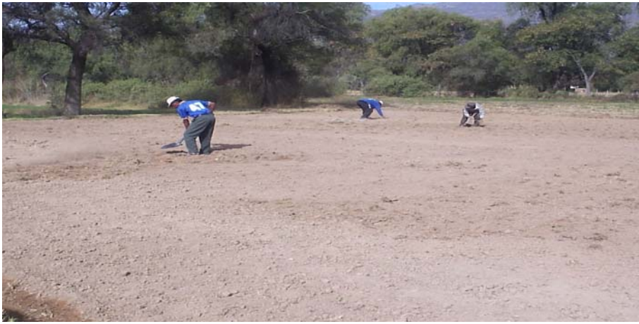
NIVELADO DEL TERRENO
