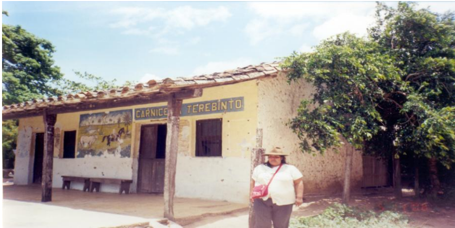
Vivienda en la zona de Terebinto
