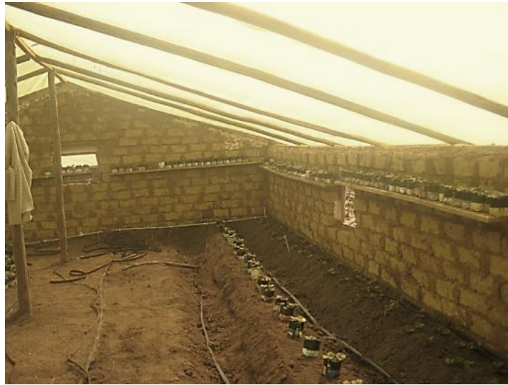
FOTOGRAFÍA 1. Preparación del terreno.
