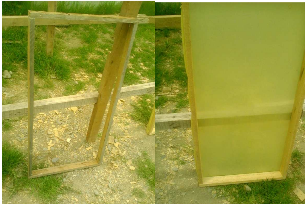
Bandejas en construcción
