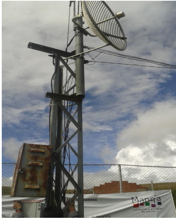
Figura 3.9: Monocanal de la población de Huarina. Fuente: Fotografía Propia
