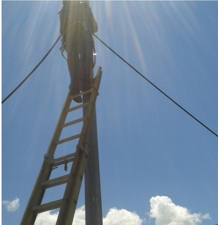
Figura 3.6: recojo de la red de Cable en la población del Palomar. Fuente: Fotografía Propia
