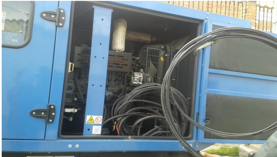
Anexo 4: Fotografía del grupo Electrónico, utilizada en casos de corte de energía mayores a 12 horas.
