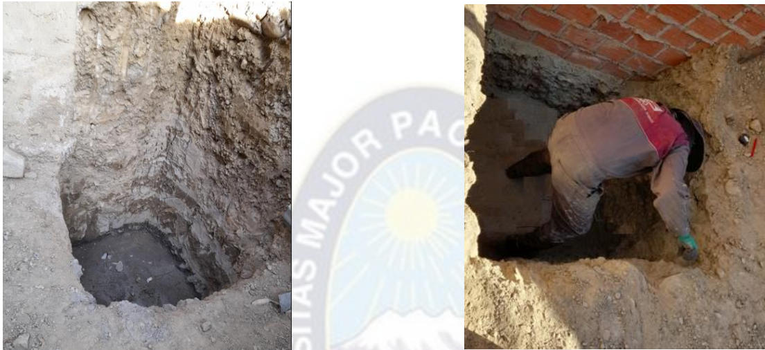
Figura 34. Excavación de Fosa Fuente: [Elaboración Propia]
