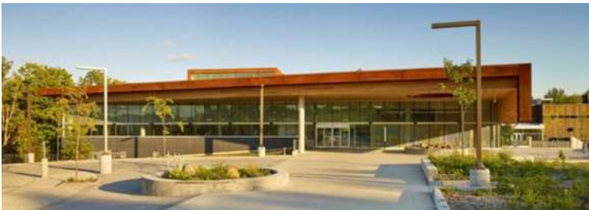
Ilustración 30. Perspectiva frontal. https://www.archdaily.cl/cl/804070/sir-sandford-fleming-college-centro-de-tecnologia-y-oficios-kawartha-perkins-plus-will
