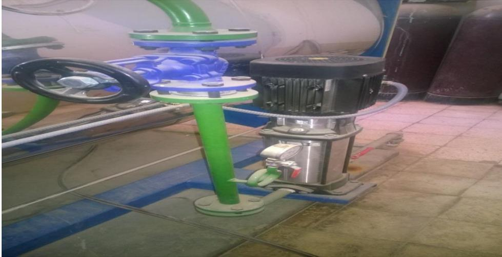
**Figura 8.** Bomba de agua-Calderas Horizontales RCB
