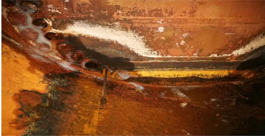
**Figura 2** Corrosión y fuga del hogar del caldero
