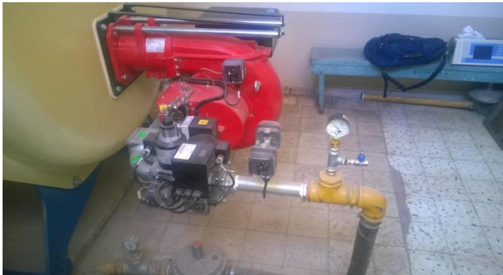
**Figura 7.** Quemador-Calderas Horizontales RCB
