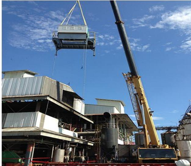
*Figura 32. Grúa de carga montaje de equipos industriales*
