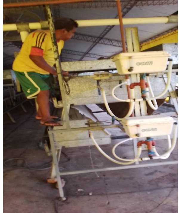
Limpieza de ductos de agua de las jaulas
