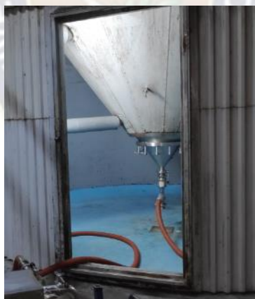
Figura 4.20 Llave de salida del tanque de fermentación conectado al sistema.
