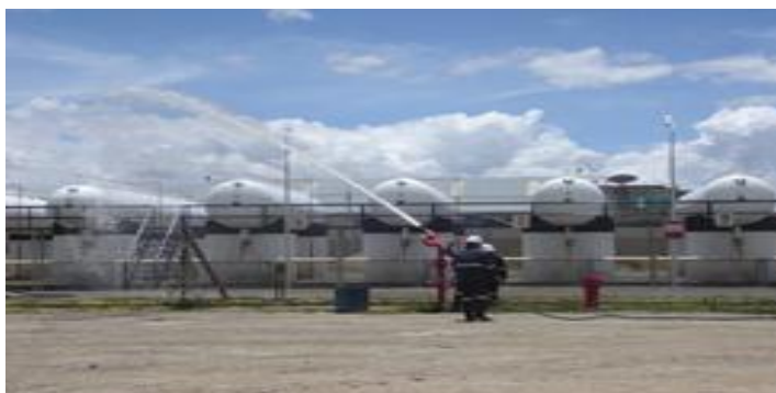
Figura 2: Tanques de almacenamiento de GLP.
