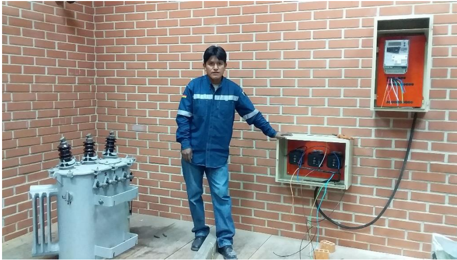
CABLEADO DE LOS CT'S AL MEDIDOR
