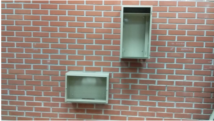
MONTAJE DE LA CAJA DE CT'S Y DE MEDIDOR
