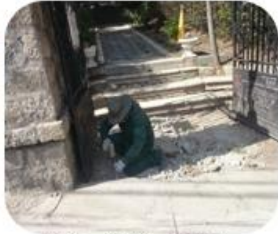
Retiro del Piso Dañado
