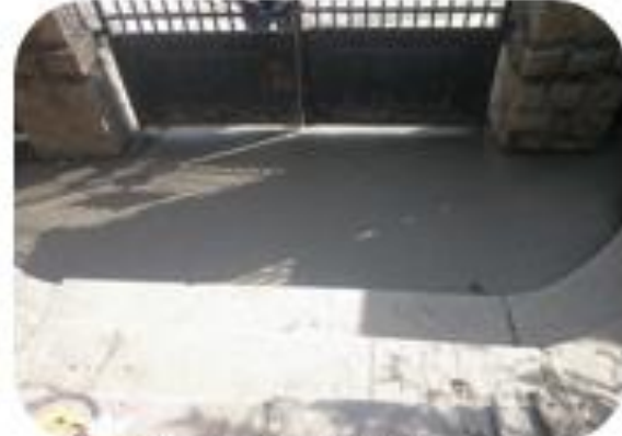
Vaciado del Piso
