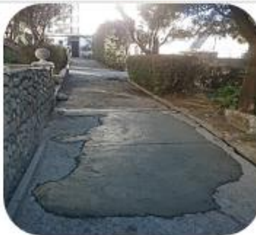
Parchado del Piso
