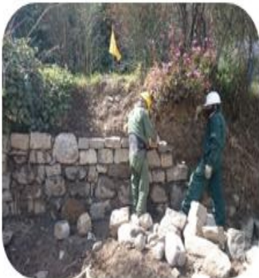
Proceso de apilamiento del Muro
