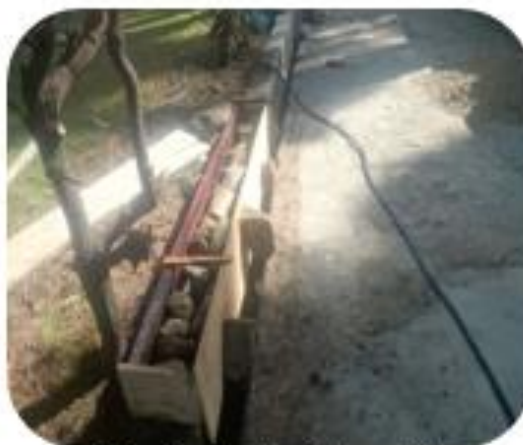
Vaciado del Cordón
