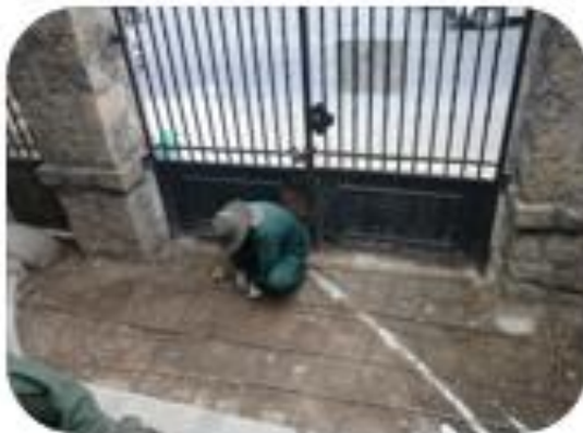
Colocado de Estructura de Fierro
