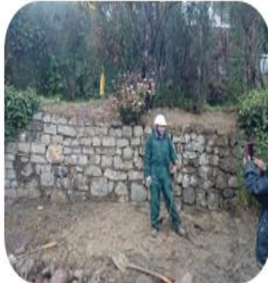
Restitución del Muro de Contención
