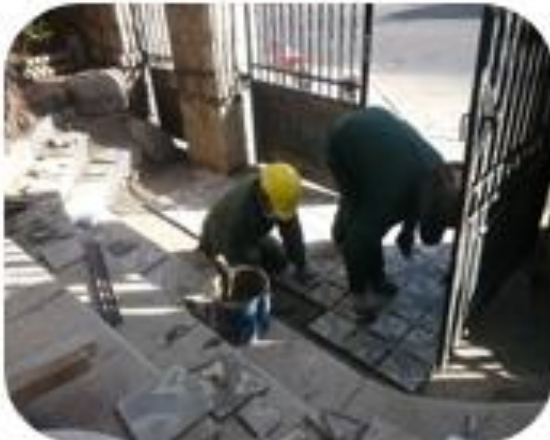
Colocado de Cerámica
