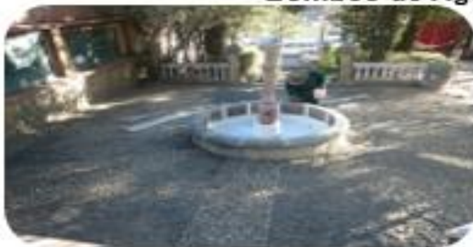
Impermeabilización de la Fuente
